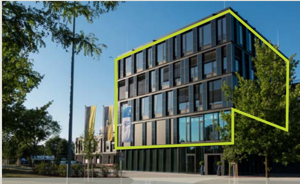
// Photovoltaik-Fassaden am ZSW-Gebäude in Stuttgart
