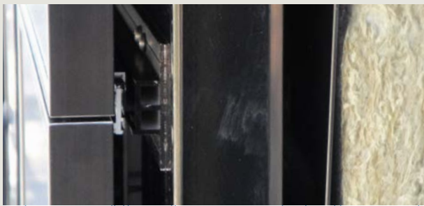
CIGS Module Riegelprofil Tragprofil Tragstruktur Unterspannbahn Wärmedämmung
