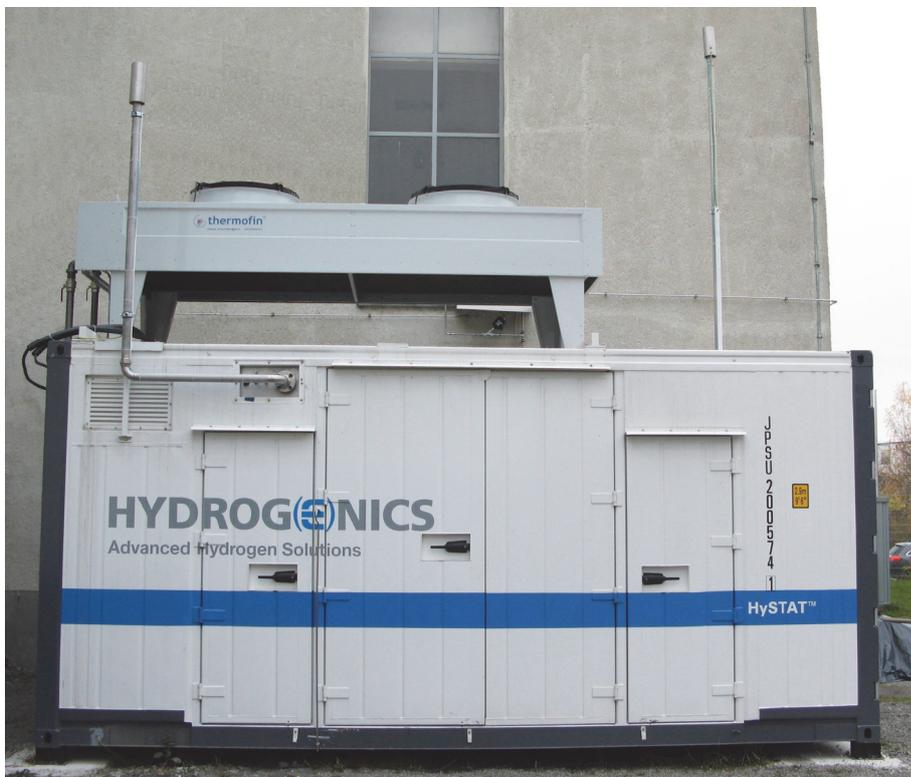
Abb. 2: 300 kW Druckelektrolyseanlage des PtG 250-Projektes in Stuttgart.
