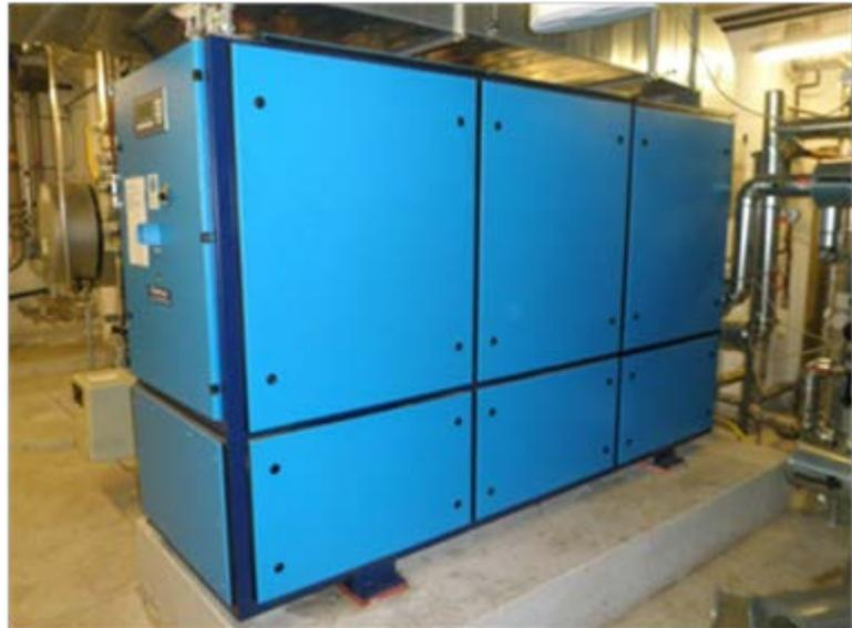
Bild 18: Blockheizkraftwerk (Stadt Stuttgart)
