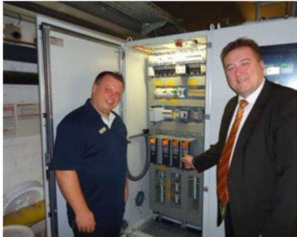
Bild 16: Technik mit hohem Einsparpotenzial: Nachträgliche Installation von Frequenzumformern für die Umwälzpumpen im Weiherhofbad (Quelle: Stadt Karlsruhe, Roland Fränkle)
