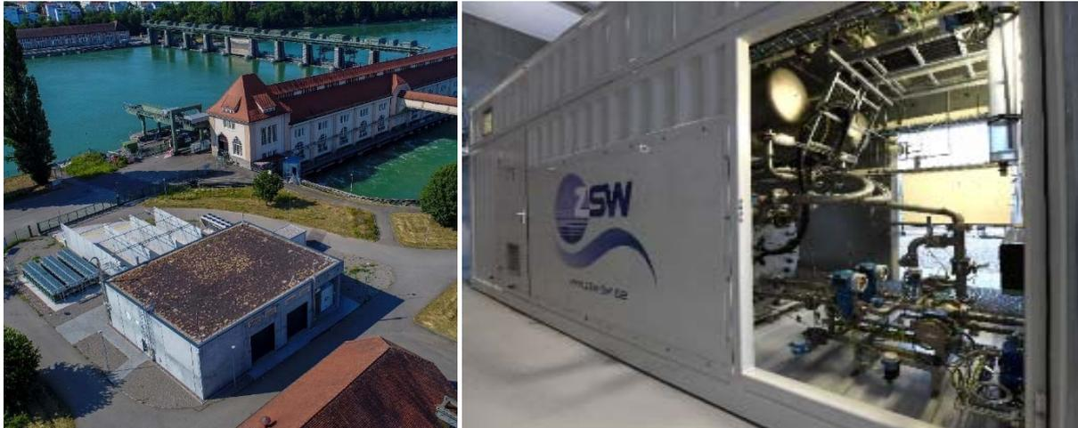
**Abb. 1:** Power-to-Hydrogen-Anlage in Grenzach-Wyhlen; rechts: Elektrolysesystem des ZSW
