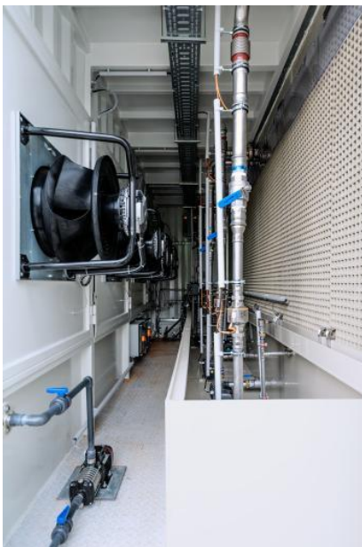
CO 2 -Absorber zur Entnahme des CO 2 aus der Luft
