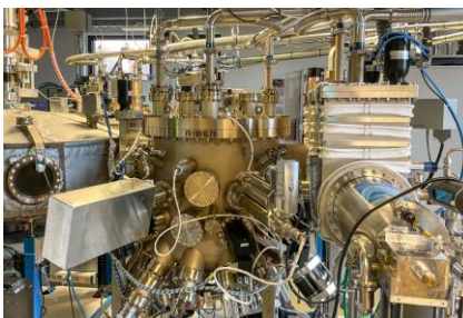
Die neue CIGS-Clusteranlage am ZSW. Foto: ZSW
