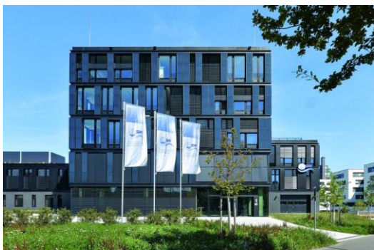
Frontalansicht des ZSW-Institutsgebäudes. Foto: ZSW / www.hochbau-fotografie.de
