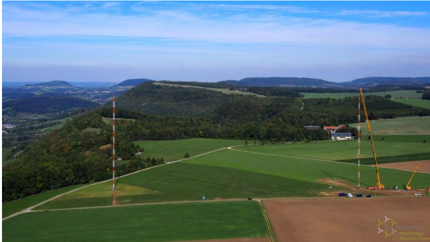
Die Errichtung der bereits stehenden Messmasten im November 2017 und September 2018.
