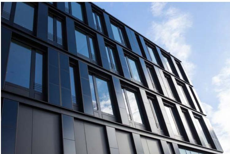
Fassade mit integrierten CIGS-Dünnschicht-Solarmodulen am Institutsgebäude des ZSW in Stuttgart (Foto: ZSW)
