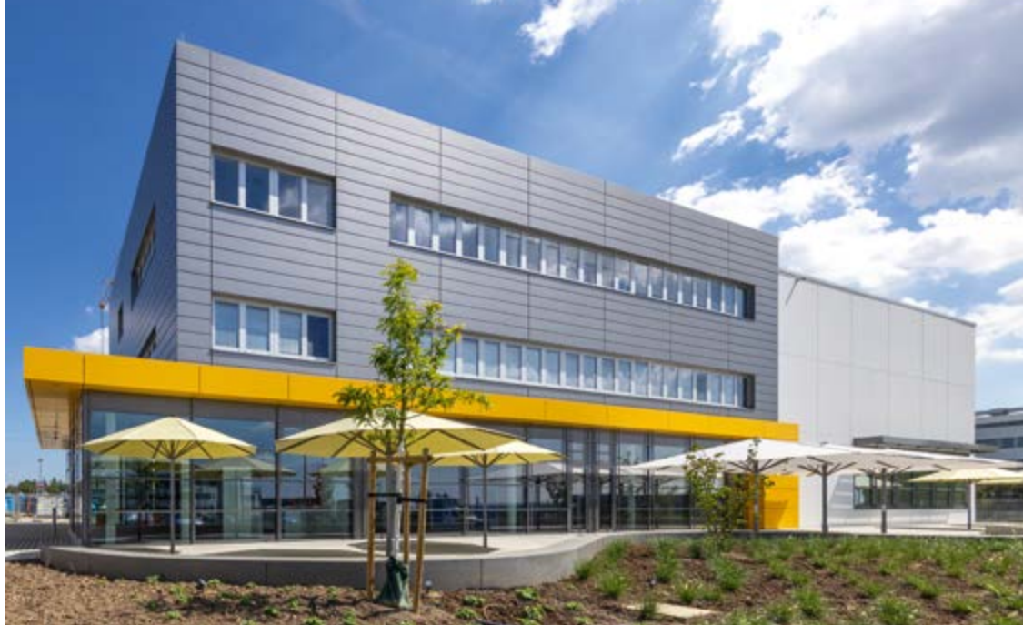
HyFaB-Neubau: Montagehalle und Seminartrakt.
