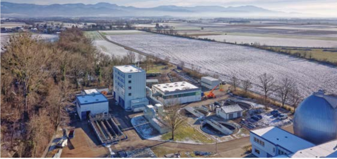
Phosphor-Rückgewinnung in der Kläranlage.
