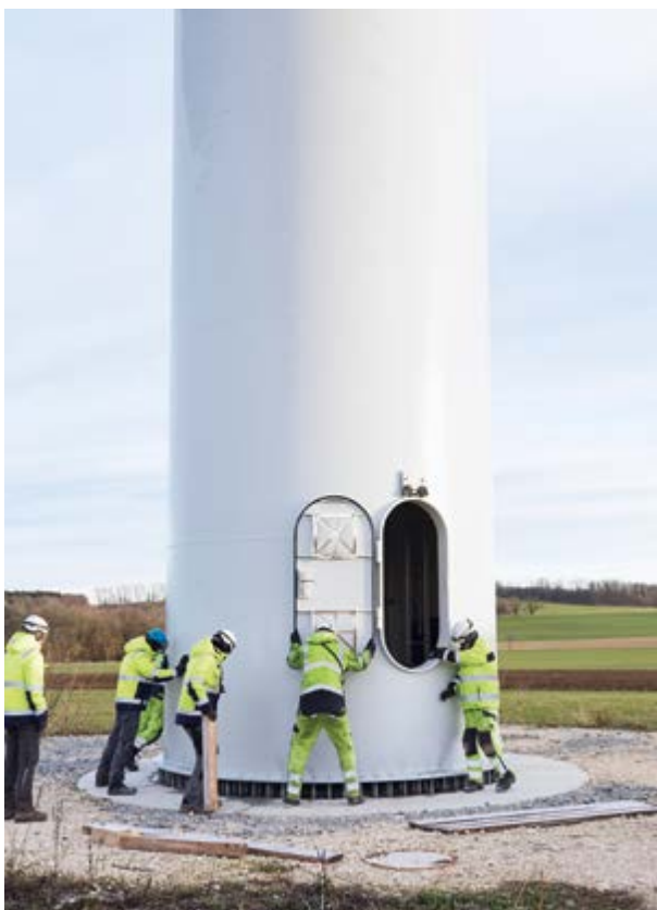
Aufsetzen des untersten Turmsegments auf das Fundament.
