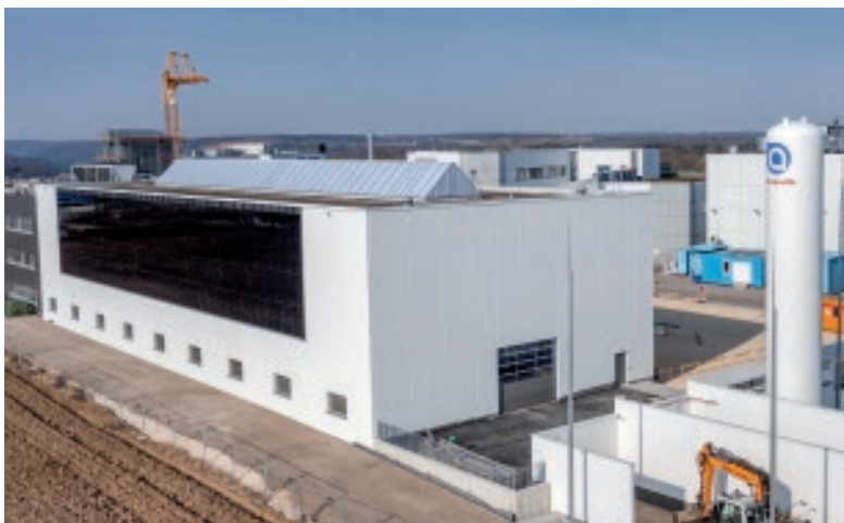
// HyFaB-Bauabschnitt 1: Brennstoffzellentestzentrum, Bürotrakt, Gaselager, im Hintergrund das eLaB. // HyFaB construction phase 1: fuel cell test centre, office wing, gas store, and the eLaB in the background.
