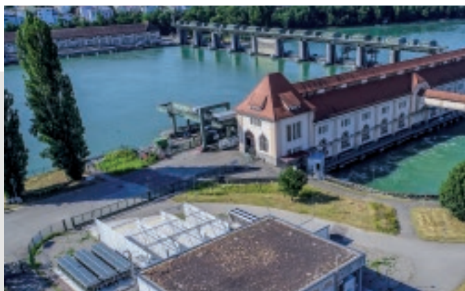
// Wasserkraftwerk mit Power-to-Hydrogen-Anlage in Grenzach-Wyhlen. // Hydroelectric power station with power-to-hydrogen plant in Grenzach-Wyhlen.
