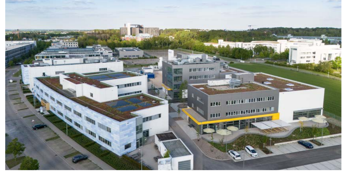
Die ZSW-Gebäude in Ulm (oben) und in Stuttgart (unten).
