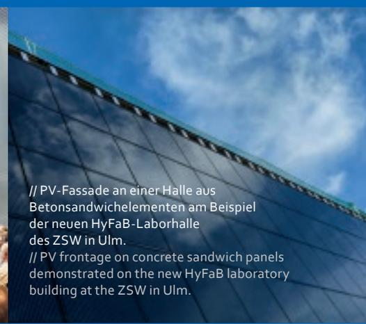
// PV-Fassade an einer Halle aus Betonsandwichelementen am Beispiel der neuen HyFaB-Laborhalle des ZSW in Ulm.
