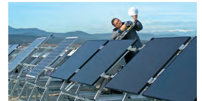
// ZSW-Mitarbeiter bei der Montage der Teststände auf dem neuen „Testfeld Süd“. // ZSW staff installing test rigs at the new “Test Facility South”.
