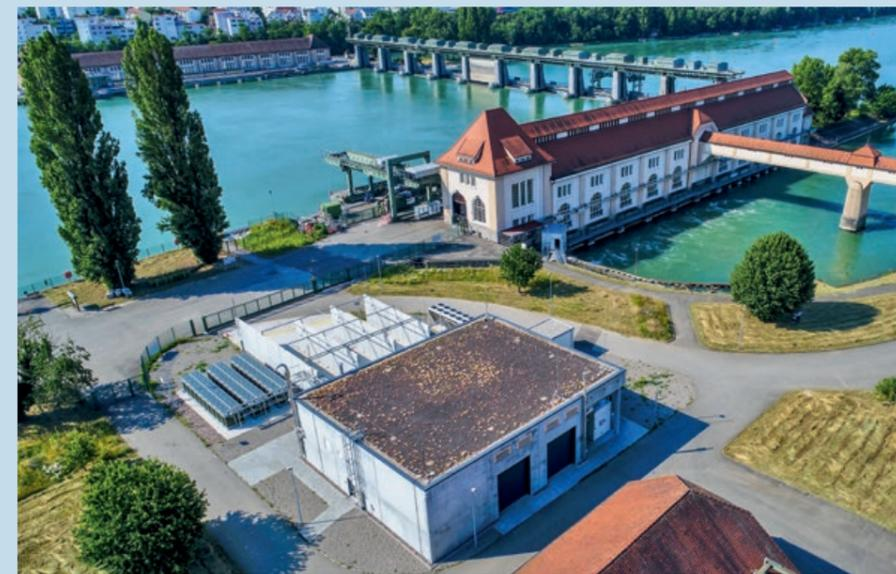
// Erzeugung von grünem H<sub>2</sub> am Wasserkraftwerk Wyhlen am Hochrhein – kommerzieller 1-MW-Elektrolyseur mit angebundener ZSW-Forschungsplattform.
