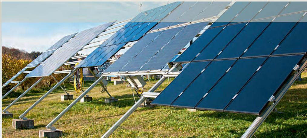
// Abb. 11: Solargeneratoren auf dem Testfeld des ZSW. // Fig. 11: Solar generators at the ZSW testing facility.
