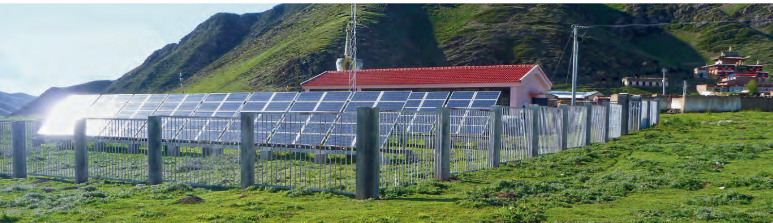
// Netzunabhängige Dorfstromanlage mit Photovoltaik. // Off-grid photovoltaic system in a mountain village.
