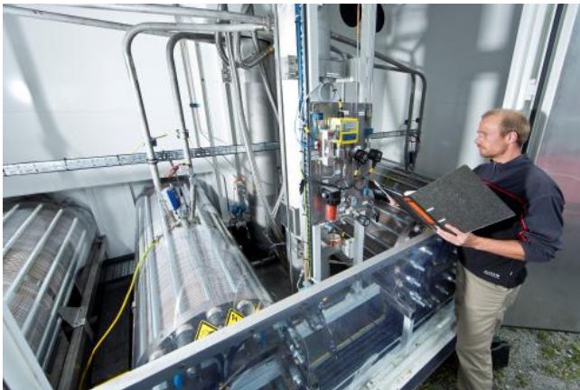
Wartung einer Elektrolyseanlage (ZSW)
