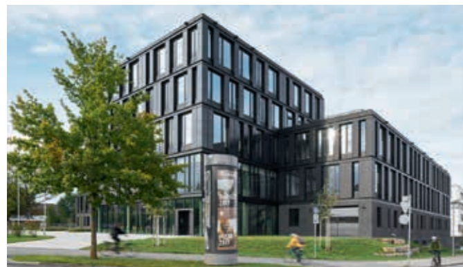
// Das neue Institutsgebäude des ZSW in Stuttgart. // ZSW's new institute building in Stuttgart.
